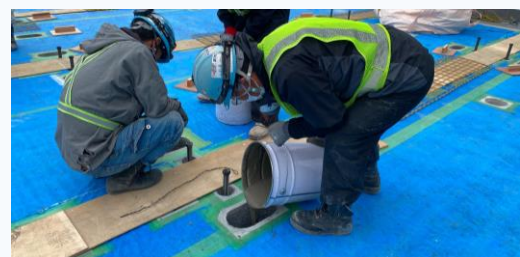
写真-2 床版下鋼桁間空隙充填状況
