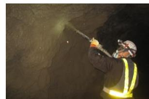
導水路の補強工(吹付け状況)
