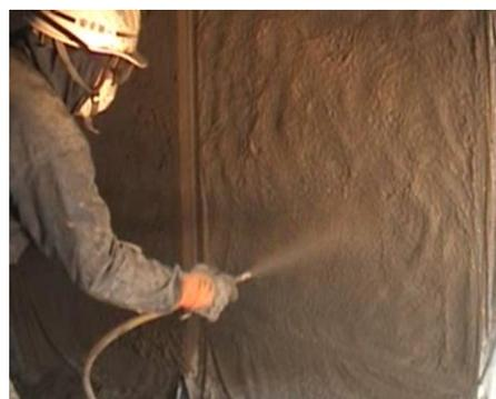
水平方向への吹付け状況
