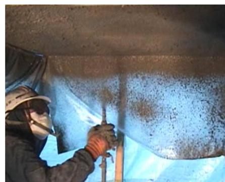
鉛直上向き方向への吹付け状況
