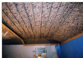
RCスラブ下面の断面補修工
