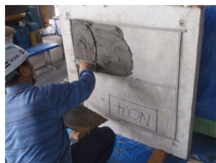
側壁塗付け状況（1層目）
