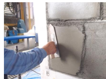
側壁塗付け状況（2層目）
