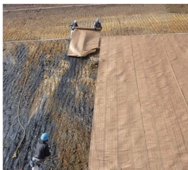
法面マットフィルター施工状況
