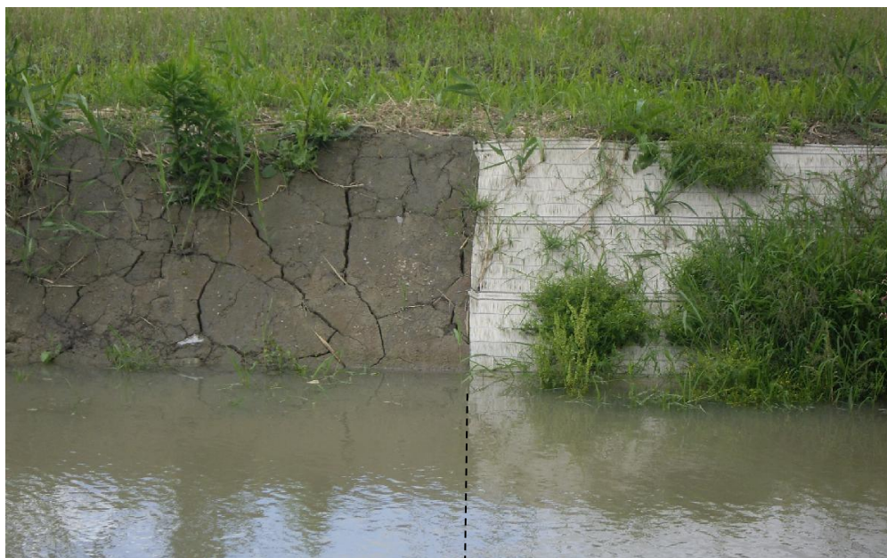
← 【底質土セメント改良土の表面】 収縮亀裂が顕著に発達 【法面マットフィルターの施工】 →
