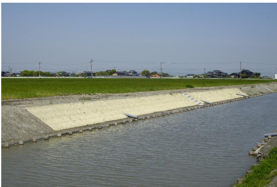
法面マットフィルターの施工完了 (種子散布なし)
