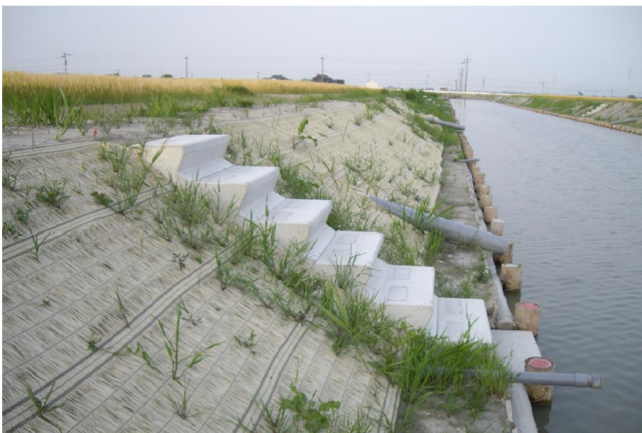
施工後2ヶ月 経過状況
